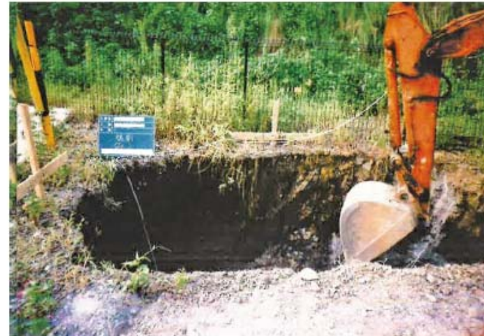
図表 2-5：埋設工事
